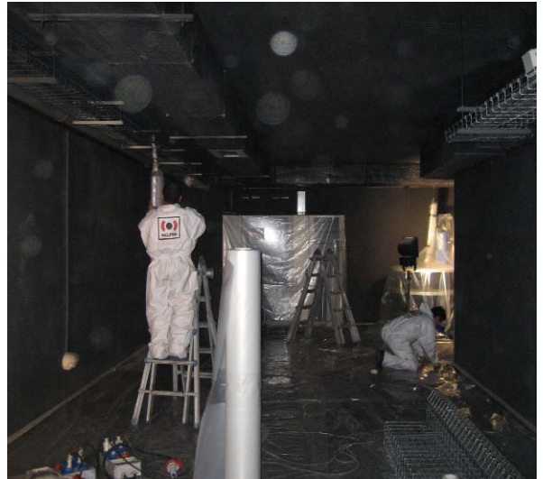
Corridoio: decontaminazione e bonifica delle strutture murarie
