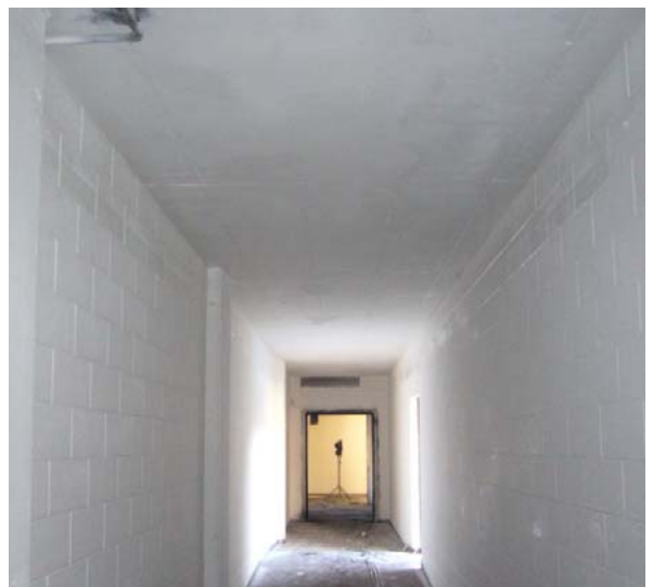
Corridoio: aspetto al termine dell'intervento
