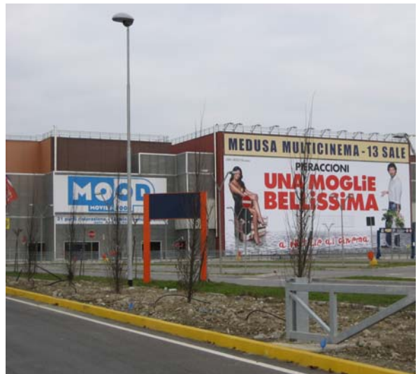
la struttura vista dall'esterno
