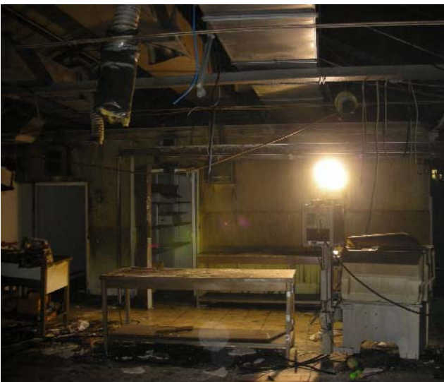
Attrezzature a pavimento ed impianti in quota prima della rimozione
