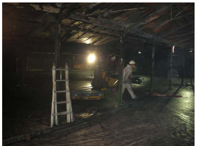
Operatori BELFOR all'opera durante le attività di demolizione e sgombero.
