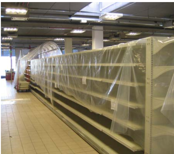
L'aspetto delle scaffalature subito dopo il sinistro ed al termine dell'intervento di decontaminazione
