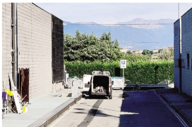
Operai ed elettricisti al lavoro il giorno dopo il rogo
