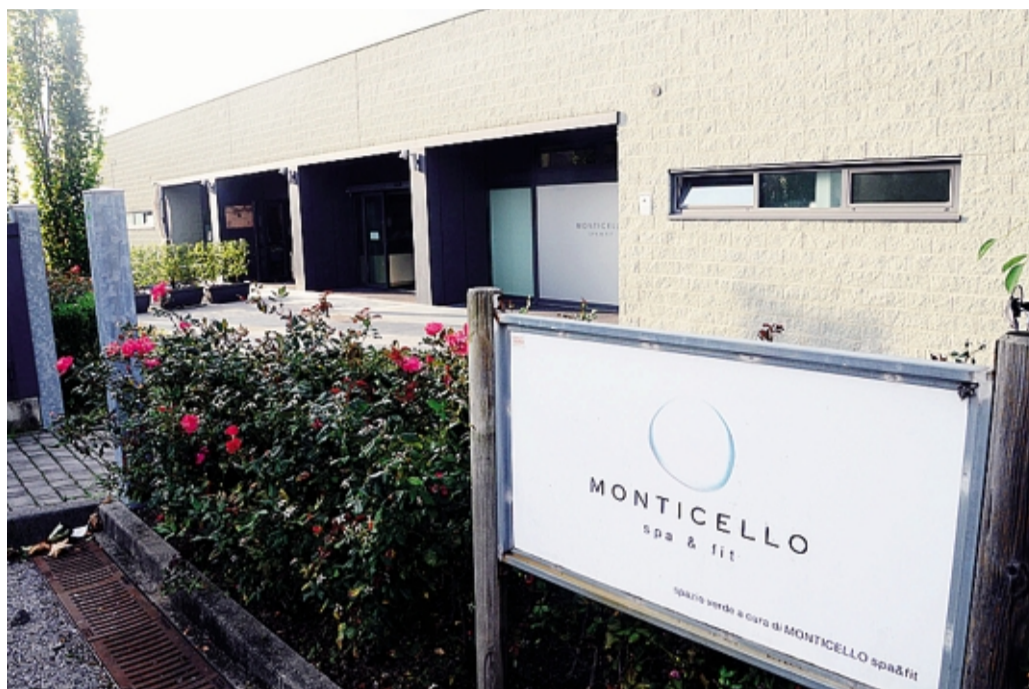
L'ingresso del centro benessere
